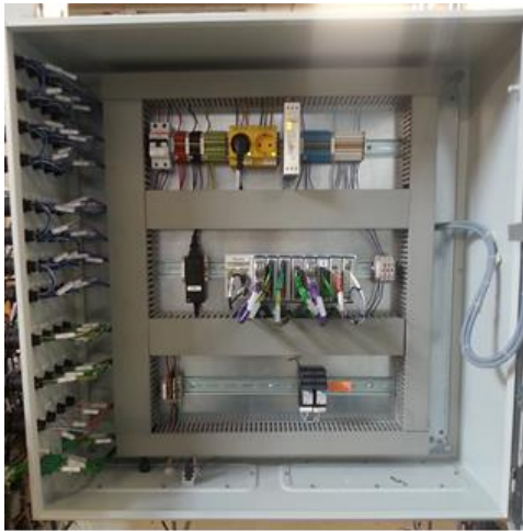
Abbildung 7: links: Schaltschrank, rechts: Blockdiagramm der modularen LabVIEW Software
